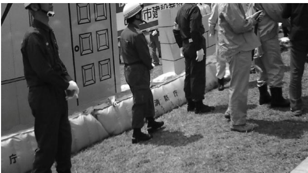
住宅浸水防止工法
