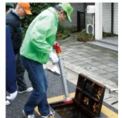
消火栓に差し込む
